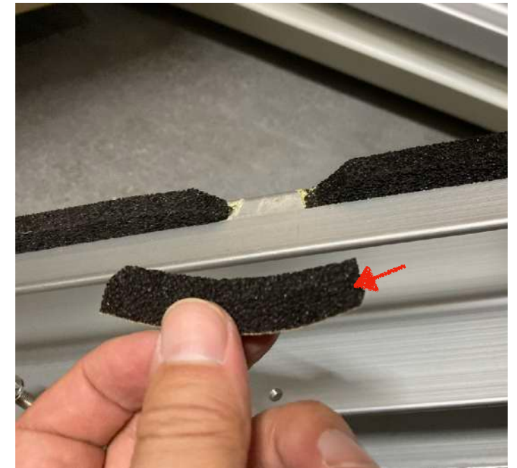
③少し大きめの新しい止水ゴムを用意します
