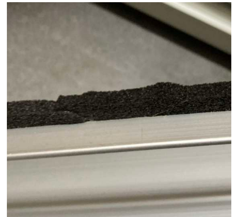
⑥補修完了
