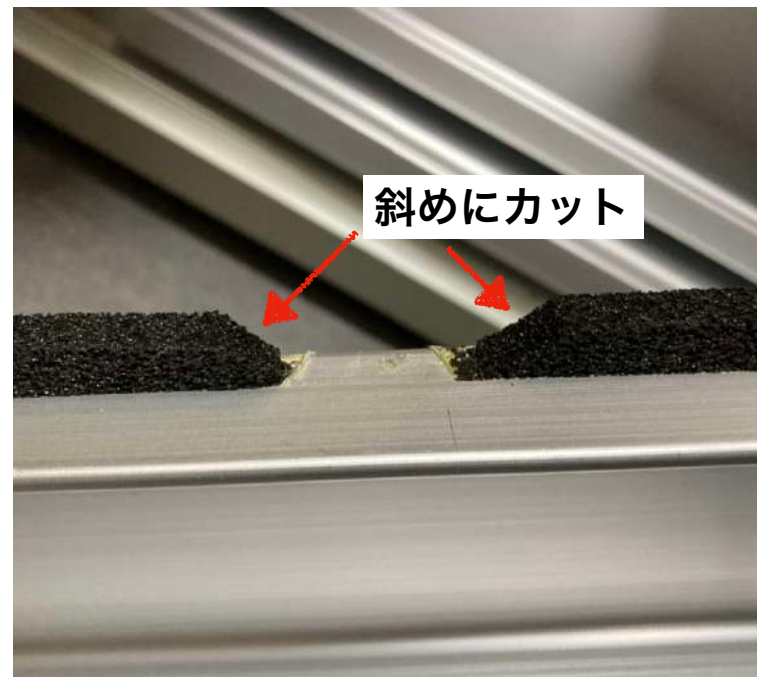
②痛んでいる部分を除去します
